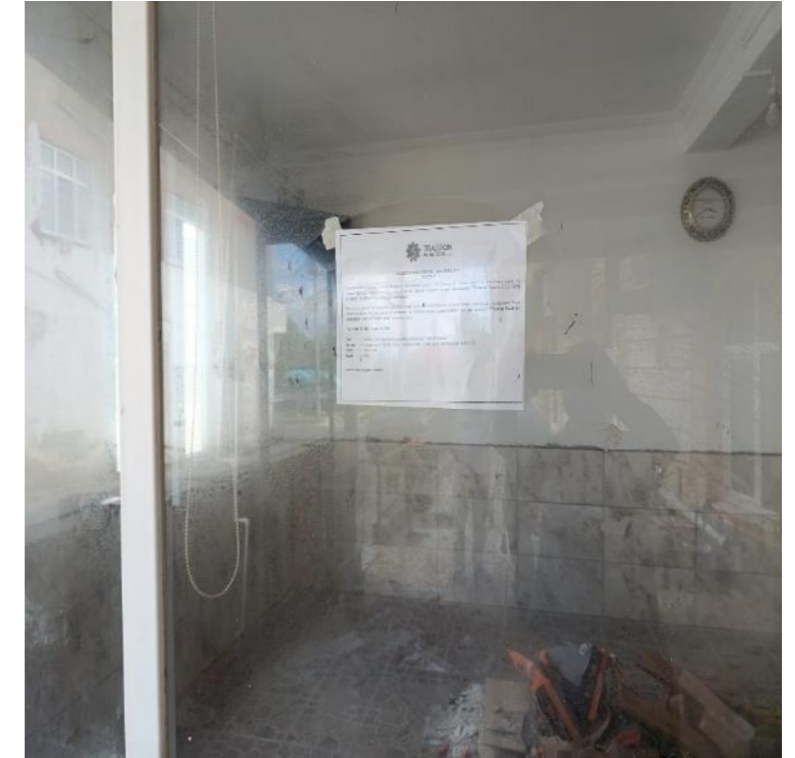
Şenkaya Mahallesi Muhtarlık Binası
