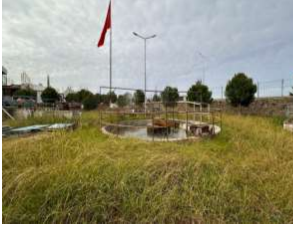
Fotoğraf 14. Dairesel Çöktürme Havuzu
