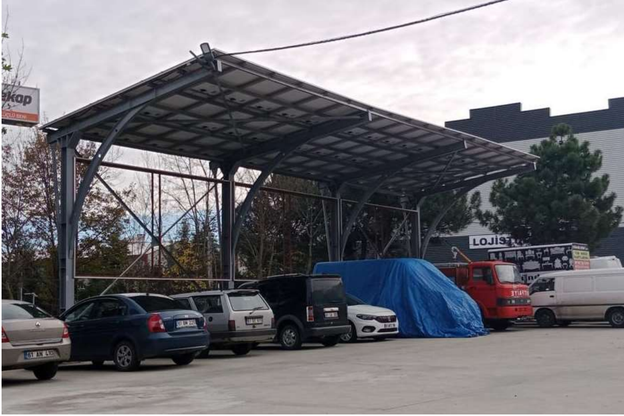
Fotoğraf 1. Proje Alanındaki Mevcut Otopark Çatısı Yapısı
