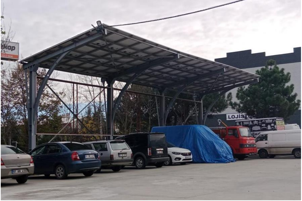
Fotoğraf 1. Proje Alanındaki Mevcut Carport Yapısı
