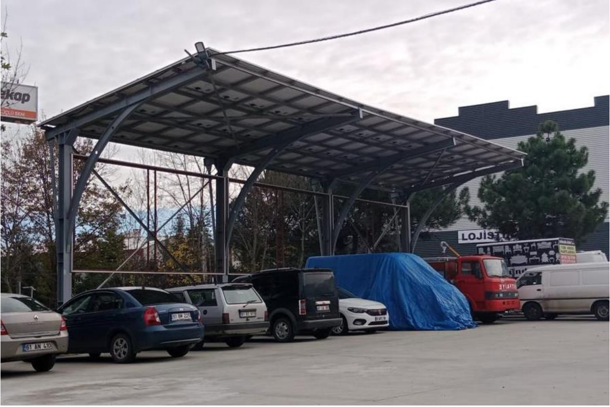
Fotoğraf 1. Proje Alanındaki Mevcut Otopark Çatısı Yapısı
