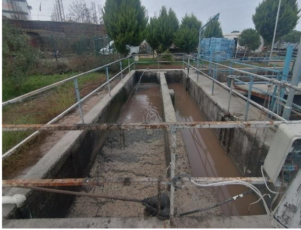
Fotoğraf 12. Havalandırmalı Kum ve Yağ Tutucu
